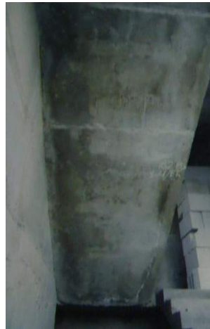
Рисунок 3. Марш 8го этажа в осях 3с-4с/Ес-Кс секции 18.2 в отм. +20,25...21,70
