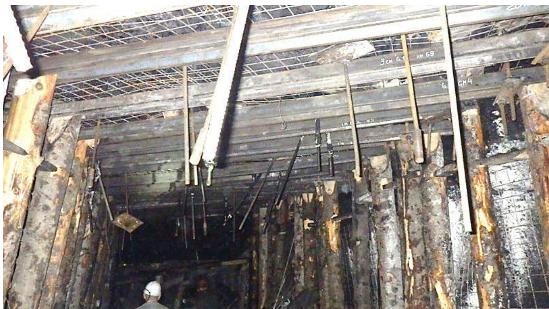
Фото 5 - изображение участка демонтажной дорожки, после выполнения рекомендаций по ее перекрепке в районе секции механизированной крепи №23
