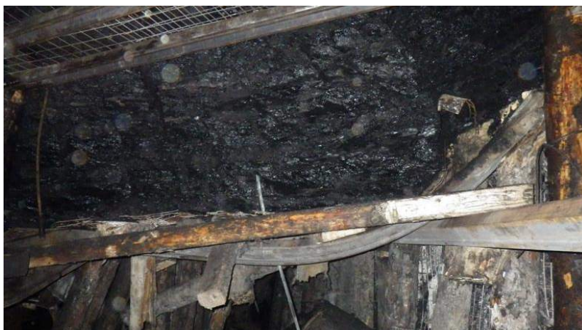
Фото 1 - Участок демонтажной дорожки в районе секции механизированной крепи №38
