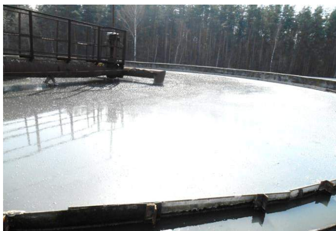
Рисунок 1. Первичный отстойник, переоборудованный в ацидофикатор
