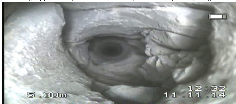
Фото 4 - Шпур №1 (расположение шпура в районе секции механизированной крепи №21 (разрушенные породы в кровле выработки на глубине 5,30 м))
