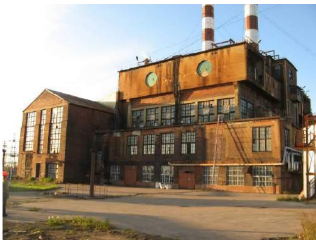
Рисунок 1. Общий вид главного фасада здания обследуемой котельной
