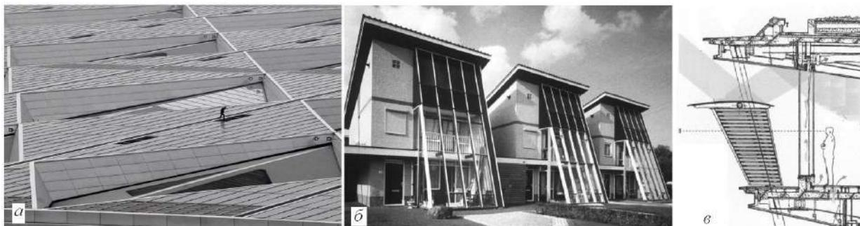
Рис. 2. Необычный вид зданий с кровлями, полностью заполненными солнечными батареями (а), с устройствами для пассивного солнечного отопления (б), с устройством для ввода солнечного света внутрь помещений (в)
