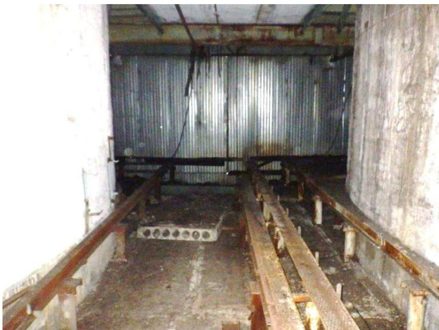
Рисунок 2. Общий вид помещений между бункерами с обрушенными конструкциями перекрытия
