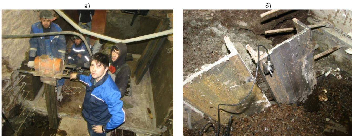
Рисунок 6. Процесс погружения шпунта при углублении подвалов (а) и измерения уровня вибрации (б)
