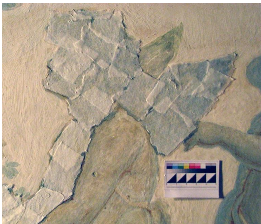
Илл. 10. Процесс удаления загрязнений компрессами из фильтровальной бумаги, смоченной водным раствором поверхностно-активного вещества.
