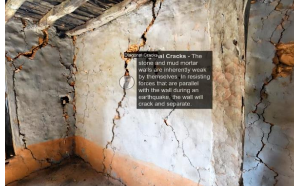
г) оценка исходного технического состояния: внутреннее пространство
