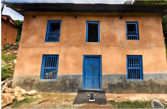
в) оценка исходного технического состояния: внешнее пространство
